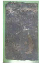
写真4 地下外壁部防水層（全体と表面拡大）
