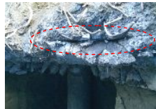
写真3 地下底盤部防水層採取の様子
