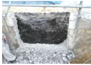
写真2 地下外壁部防水層採取の様子
