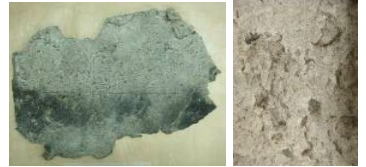
写真5 地下底盤部防水層（全体と表面拡大）
