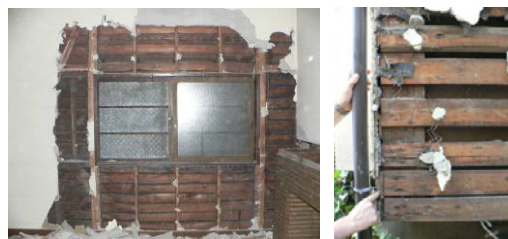
写真 2 解体におけるラス下地板の様子
